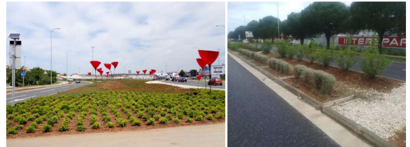
Slika 78 Kišni vrtovi pulske obilaznice (Starum d.o.o., 2017.)
